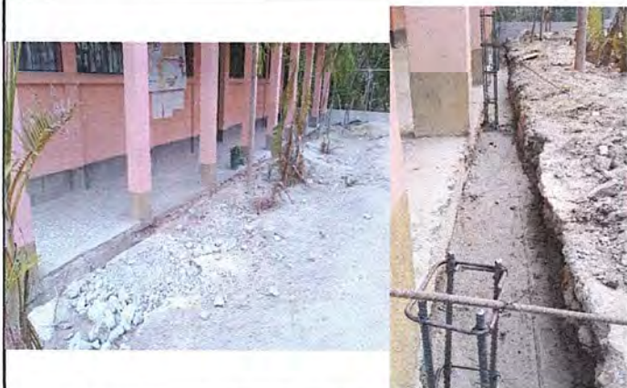
Foto 3: Vista del avance del muro de canal y mejoramiento del canal de aguas pluviales con block y su respectiva parrilla de metal frente dos aulas del centro educativo.
